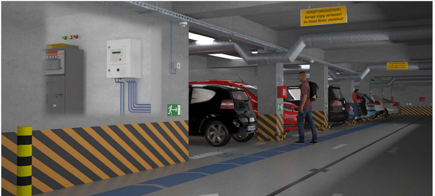
Beispielhafter Aufbau einer SCENTY® Gaswarnanlage in einer Tiefgarage
